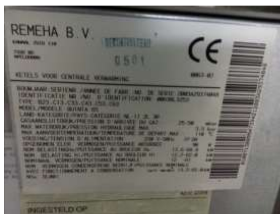
Foto 7 en 8 : De aanwezige C.V. installaties zijn niet asbestverdacht.
